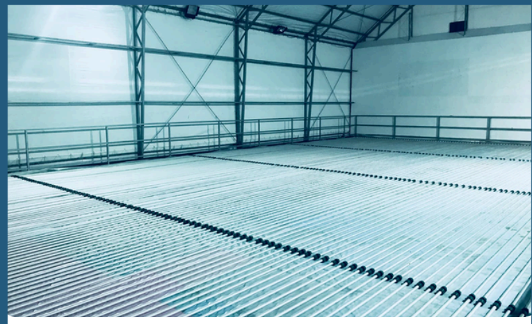
Doğal Buz Pisti Alt Yapı Sistemi
